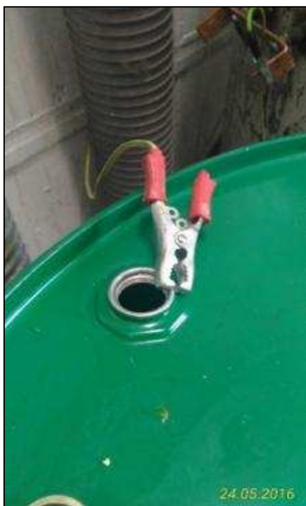
Pinza non correttamente connessa
